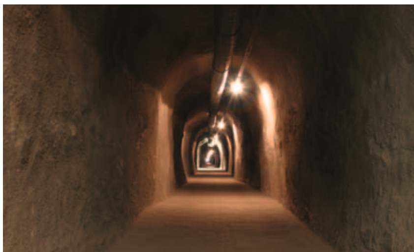
Tief in die Erde: der Barbarastollen bei Oberried. (Fotos: BBK)
