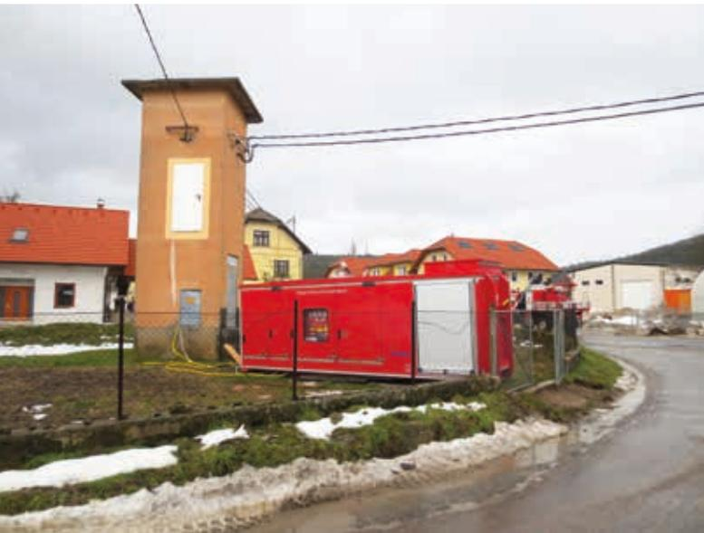
Ein Notstrom-Großaggregat speist Strom in das öffentliche Stromnetz ein.
